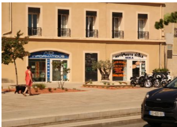
Devantures commerciales intégrées au bâtiment
