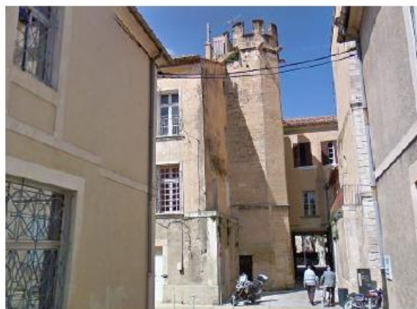
Escalier en vis - passage VIDAU
